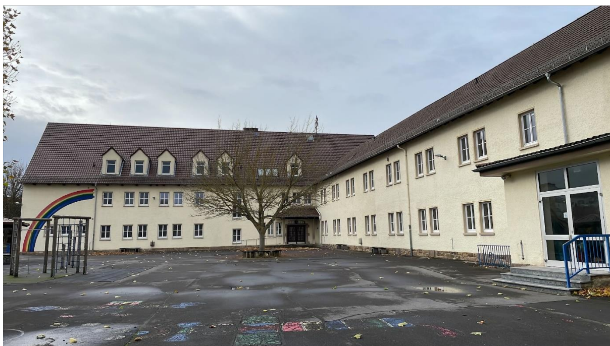
Abbildung 23: Regenbogenschule, Blick vom Schulhof
