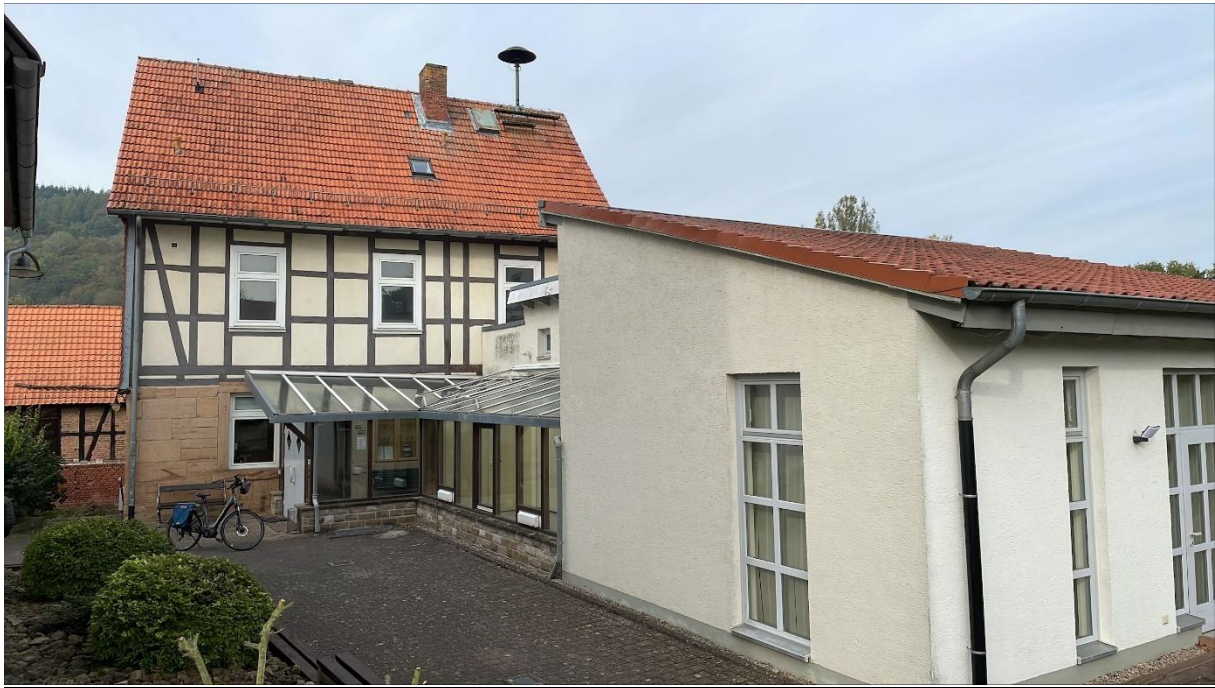
Abbildung 25: DGH mit Blick aus Süd/Ost. Wohnhaus im Hintergrund mit aktuellem Standort der Heizzentrale
