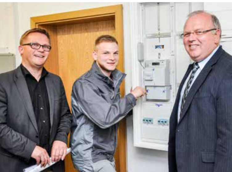
Im Rahmen eines Praxistests baut EAM-Monteur Daniel Blum das erste intelligente Messsystem im Rathaus von Zierenberg ein. Mit dabei Bürgermeister Stefan Denn (links) und der Leiter der EAM-Netzregion Baunatal/Hofgeismar Andreas Schneider.
