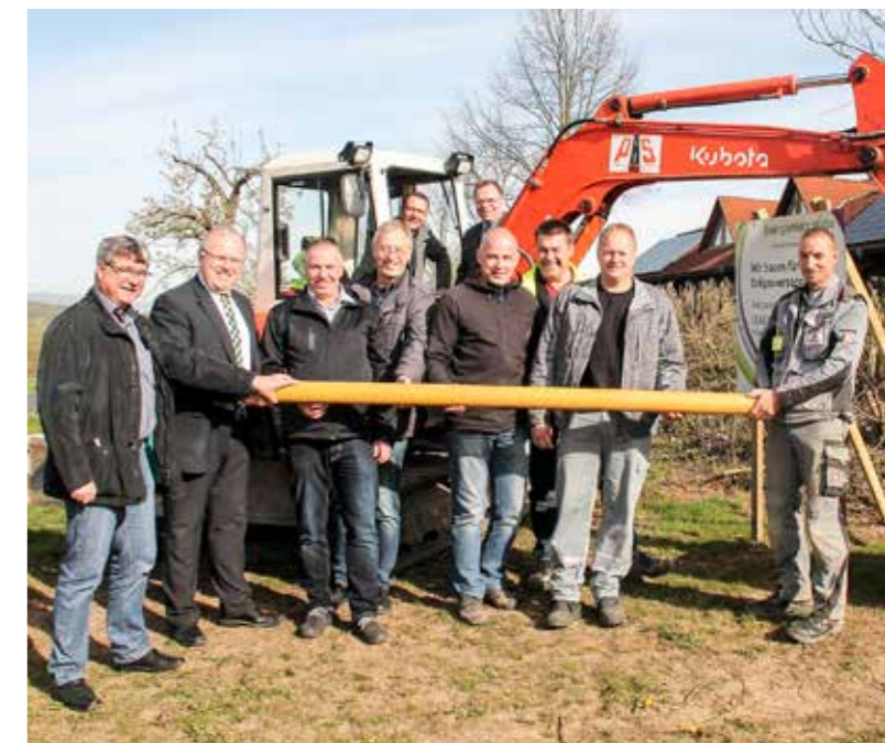
Start der Baumaßnahmen für die Erdgasversorgung des Melsunger Stadtteils Röhrenfurth. Mit dabei (hinten v. l.): Melsungens Bürgermeister Markus Boucsein und der Landrat des Schwalm-Eder-Kreises Winfried Becker.
